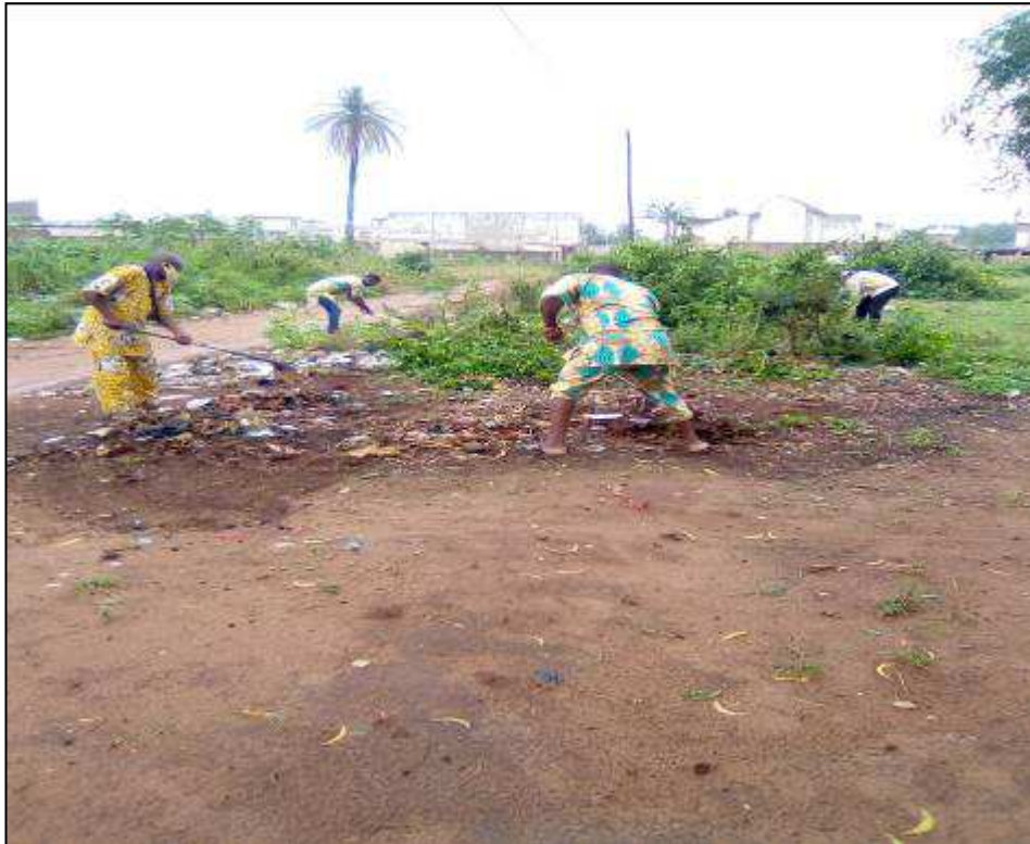
Destruction d'un dépotoir sauvage à Yèvié, Commune d'Adjarra
