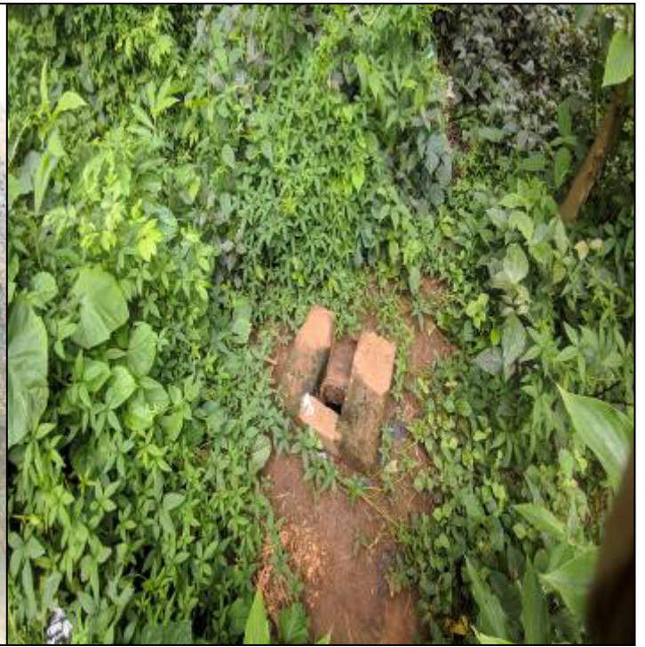
Latrine mal entretenue et dans la brousse recensée à Agbadomè dans Anianlin
